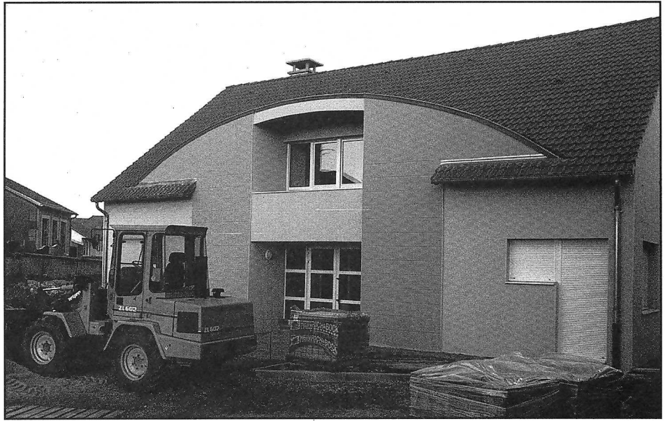
Les engins de Bâti-TP ont envahi la place de la mairie
