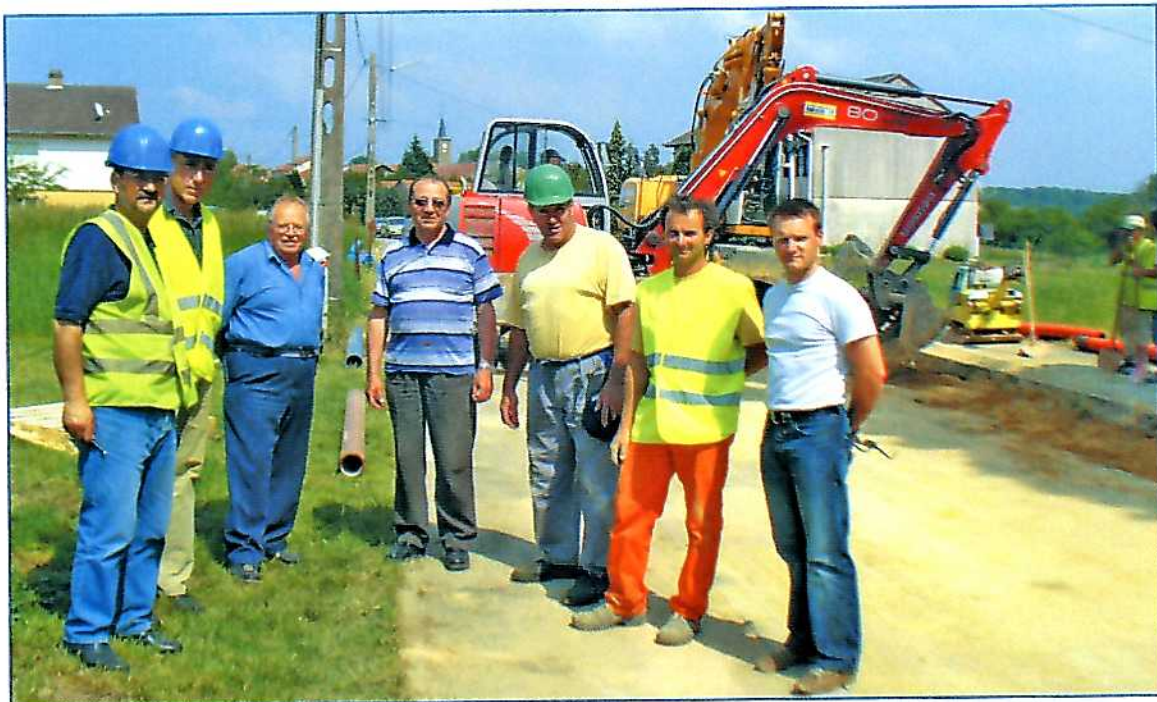
Réunion de chantier rue de la Nied
